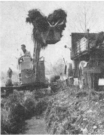
Arbeit mit dem Grabenlöffel
