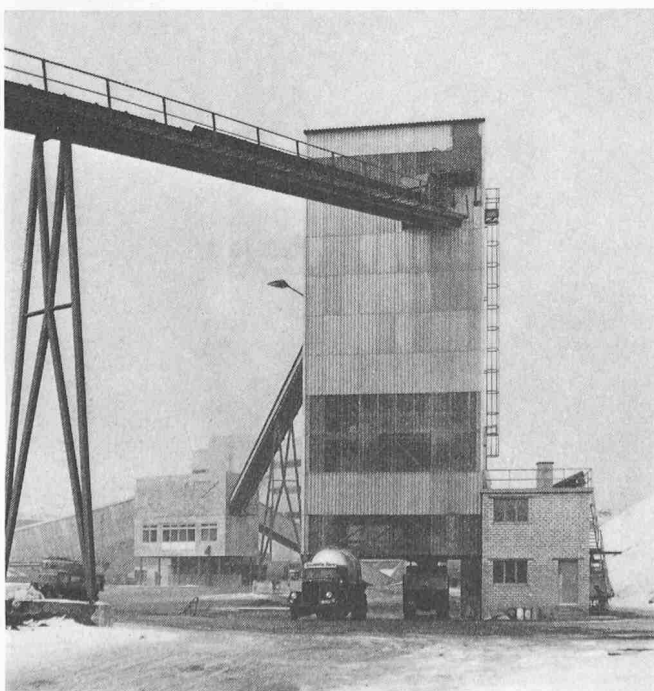
Bild 16. Anlage für die Herstellung von Fertigbeton
