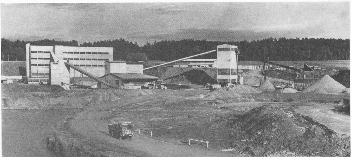
Bild 2. Ansicht der Anlagen von der Bern-Thun-Strasse aus
