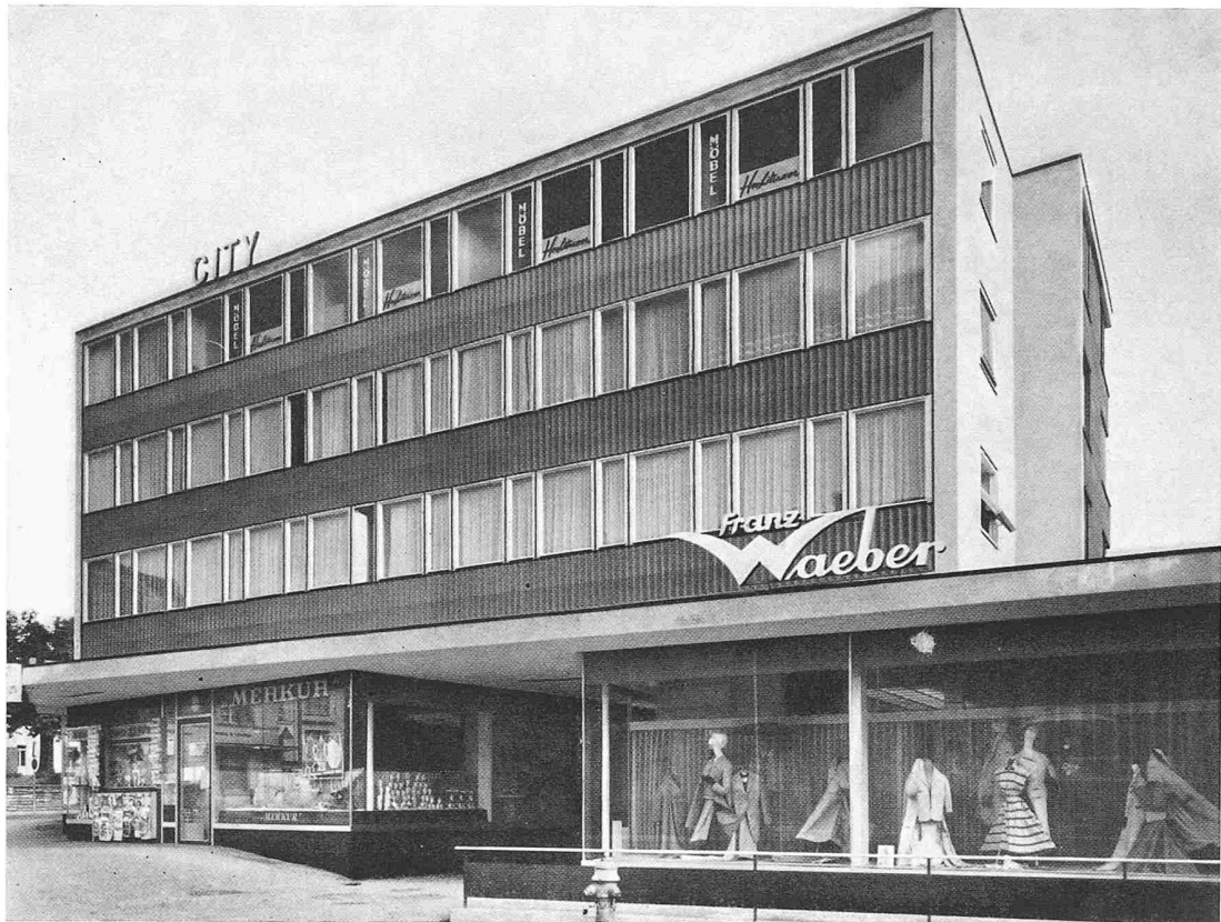
Ansicht aus Nordosten
