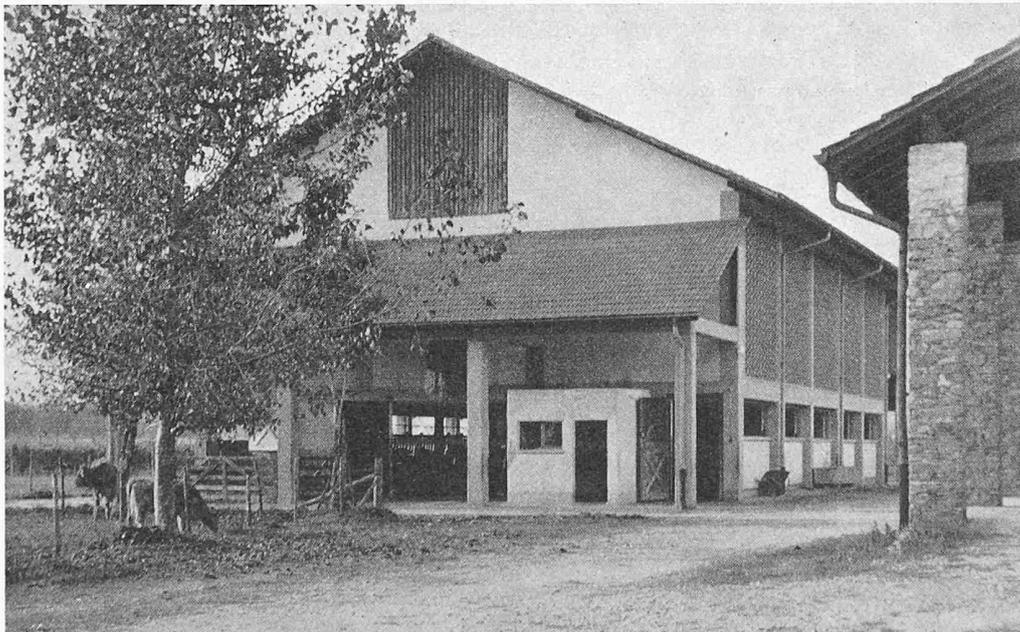
Ansicht aus Südosten. Unter dem Vordach nachträglich, im Zusammenhang mit der Einführung der Melkmaschine, eingebaute Milchkammer
