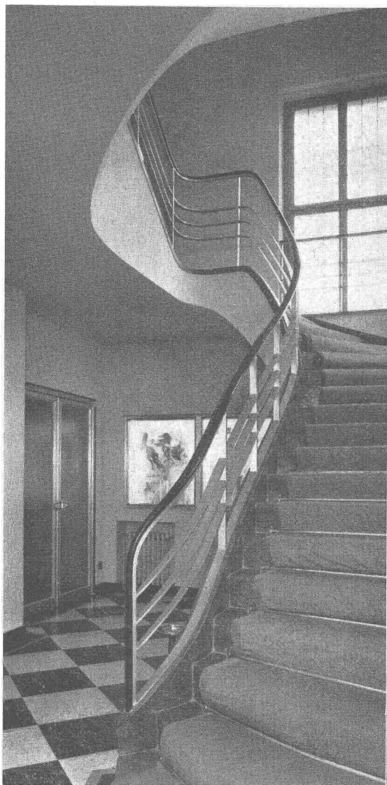
Geländer in Altenrhein eloxiert
