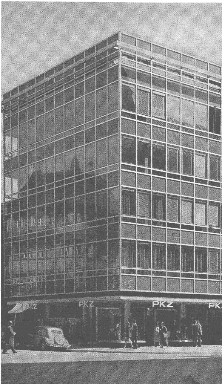
(Haus Waltisbühl, Zürich Architekt S.I.A. R. Zürcher)
