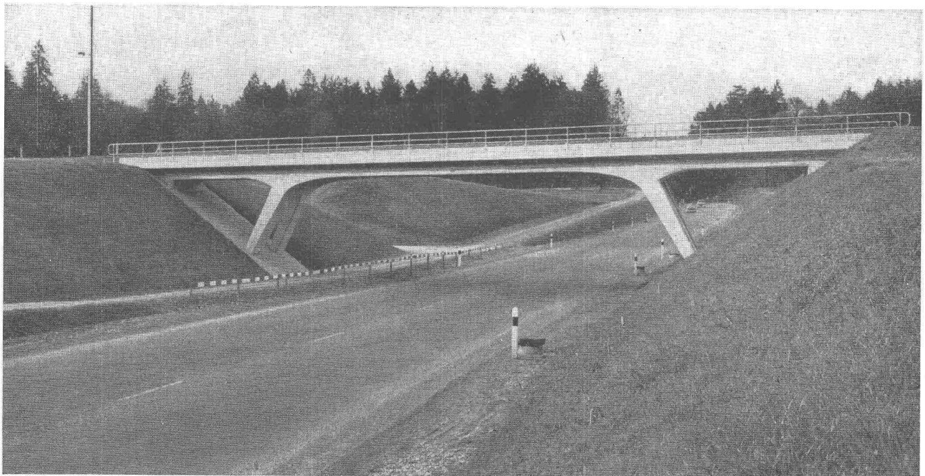
Bahnüberführung im «Stigli» Projekt: P. Soutter, dipl. Ing.
