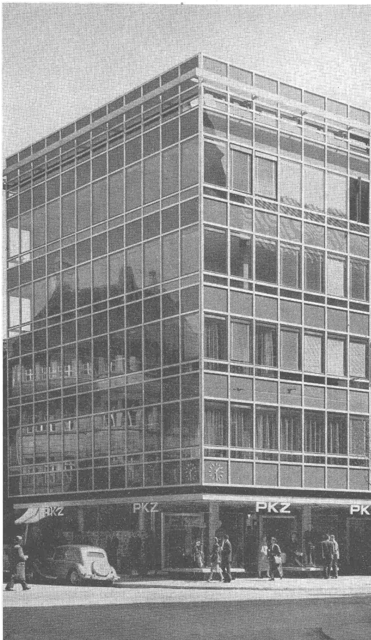
(Haus Waltisbühl, Zürich Architekt S.I.A. R. Zürcher)
