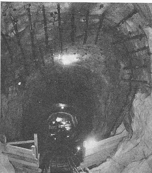
Bild 6. Ankerung durch Keilschlitzanker, Netz und Profileisen im 45° geneigten Schrägschacht des Kraftwerkes Forçacava (Brasilien); F = 44 m 2
