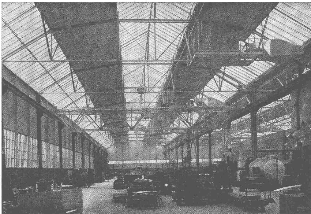
Produktionshalle, Krangerüst in Leichtmetall
