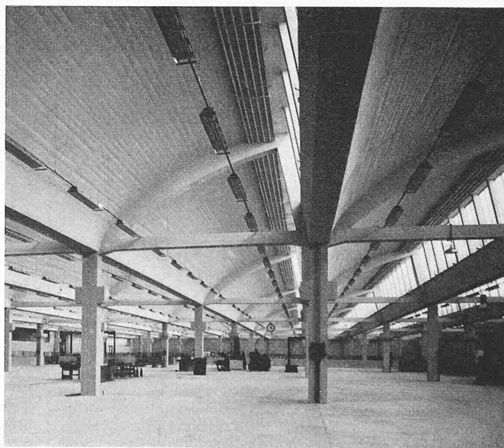
Bild 3. Hochtemperatur-Strahlungsheizung in einer Maschinenfabrik. Die Bandstrahler sind zwischen den Sheds angeordnet
