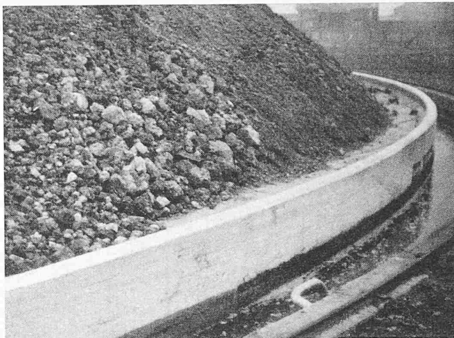
Bild 15. Grobes und feines Tropfkörpermaterial wahllos aufgeschüttet
