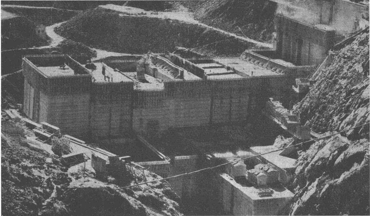
Staumauer Grande Dixence. Betonierung mit Zusatz von BARRA-55-Vinsol (1. Phase von 1 800 000 m<sup>3</sup> Beton)
