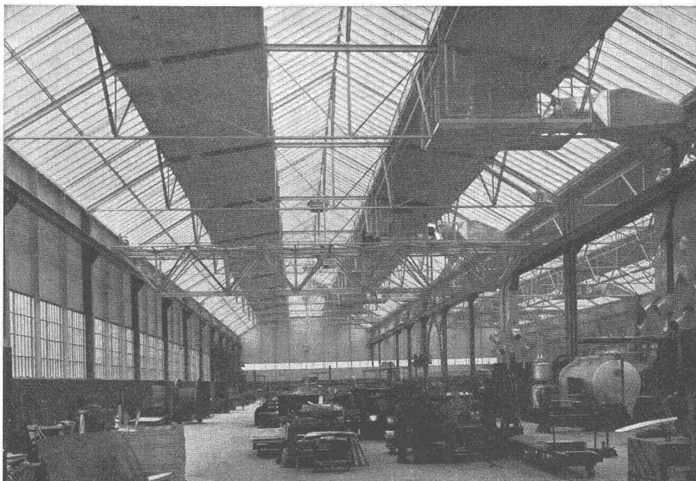
Produktionshalle, Krangerüst in Leichtmetall
