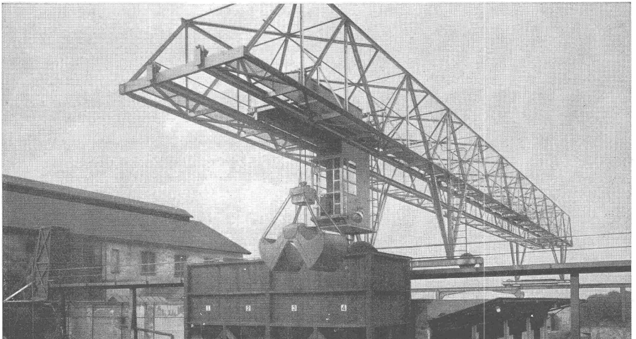
Verladebrücke in Schweisskonstruktion 2,5 t Tragkraft, 46 m Länge
