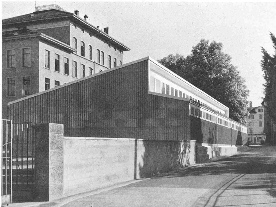
Strassenansicht aus Nordosten
