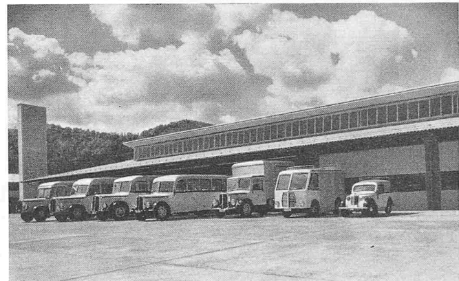
PTT-Garagen, Arch. E. Brantschen, St. Gallen
