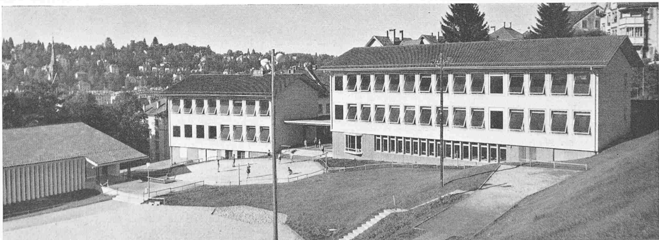
Primarschulhaus Tschudiwiese, Arch. E. Brantschen, St. Gallen
