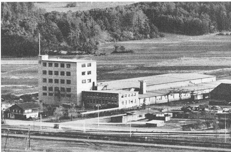
Bild 24. Gebäudekomplex der Fibron S. A., gesehen von Nordwesten
