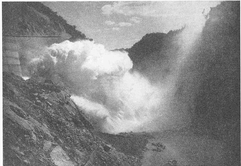
Bild 6. Probelauf zu Bild 3 mit 230 m 3 /s (Vollast 1100 m 3 /s) zwecks Prüfung der zerstörenden Wirkung der Anordnung
