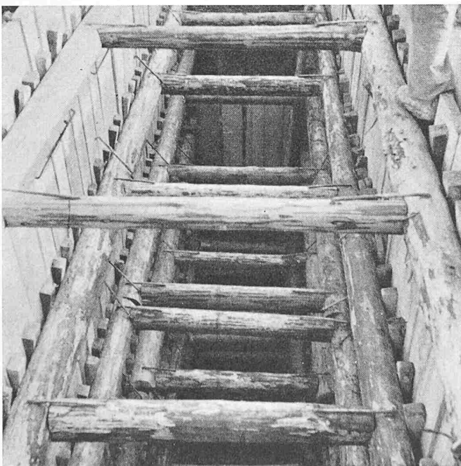
Die Spriessung im ausgehobenen Sporren in Axe 8; Tiefe 12 m
