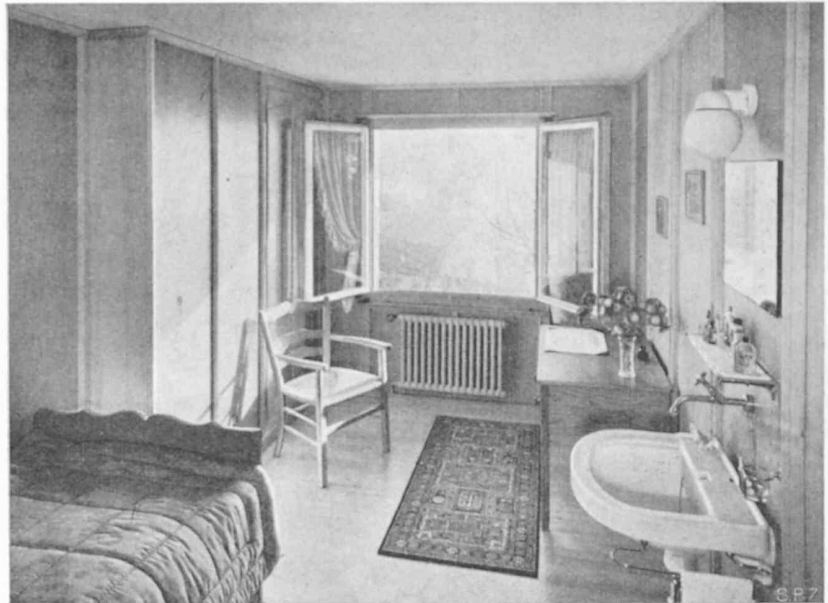
Bild 10. Normales Einz Zimmer des Obergeschosses. Naturfarbenes Limbatäfer, mit Leisten zwischen die sichtbare Tragkonstruktion eingesetzt
