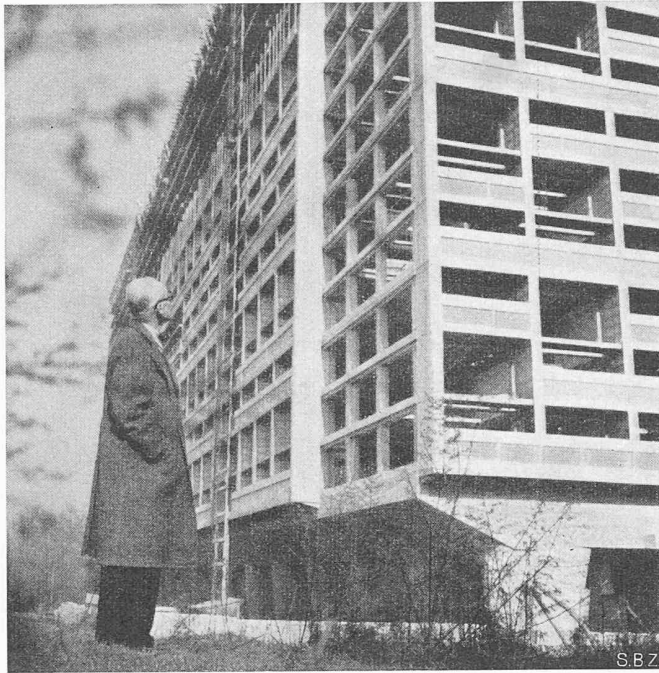
Bild 8. Aussenansicht des Rohbaues
