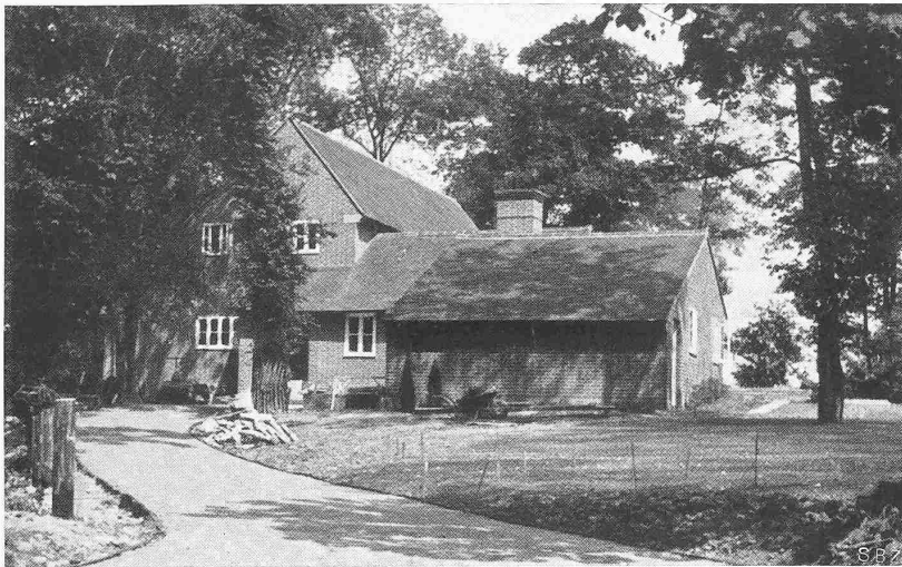
Abb. 3. Westseite mit Anfahrt im Sommer
