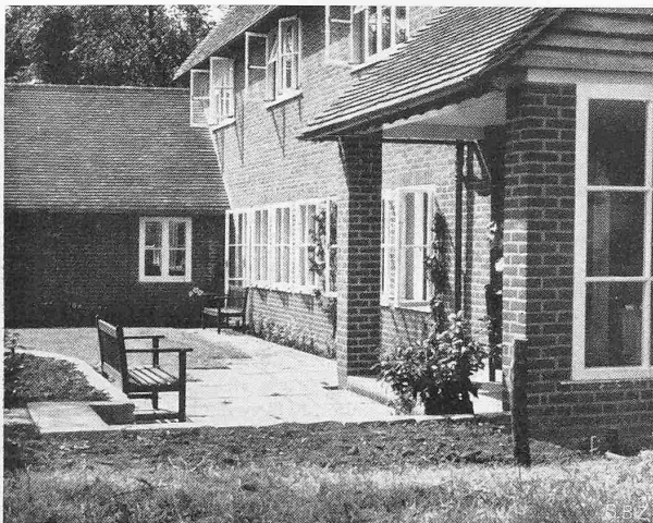
Abb. 8. Loggia und Südassade im Gartenhof Bodenbelag aus grauen Sandsteinplatten
