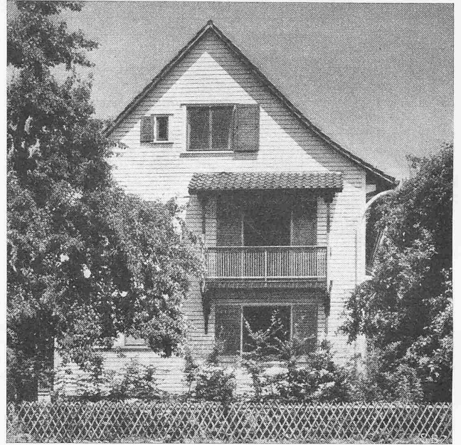
Abb. 3. Südwestseitige Giebelfront gegen die Strasse
