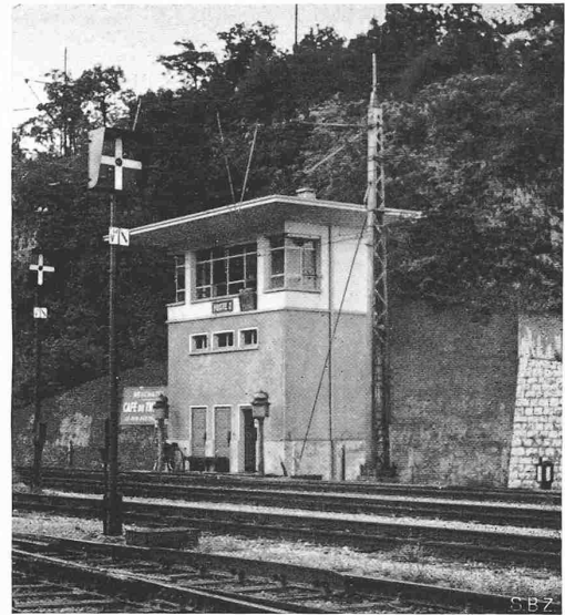
Fig. 3. Poste II d'enclenchement faisceau marchandises
