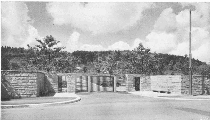
Abb. 2. Der neue Haupteingang zum Friedhof Nordheim, an der Wehntalerstrasse
