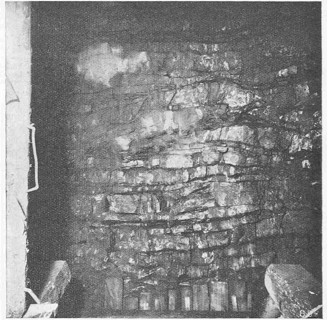
Abb. 7. Flysch-Schiefer bei Hm 1,90 Süd (bergseitiges Widerlager) Sämtliche Photos Rich. Aschwanden, Altdorf
