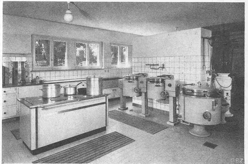
Abb. 6. Küche mit elektrischem Herd und Dampf-Kochapparaten
