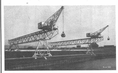
Eisenkonstruktion zu zwei Verladebrücken am neuen Hafenbecken Basel - Kleinhüningen Länge je 95 m, Stützweite je 65 m, Gesamtgewicht beider Brücken 370 t, Fahrbahn ca. 170 t, Baujahr 1939.
