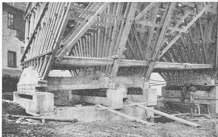
Abb. 21. Linksufriger Gerüstfuss auf den Auflager-Sätteln
