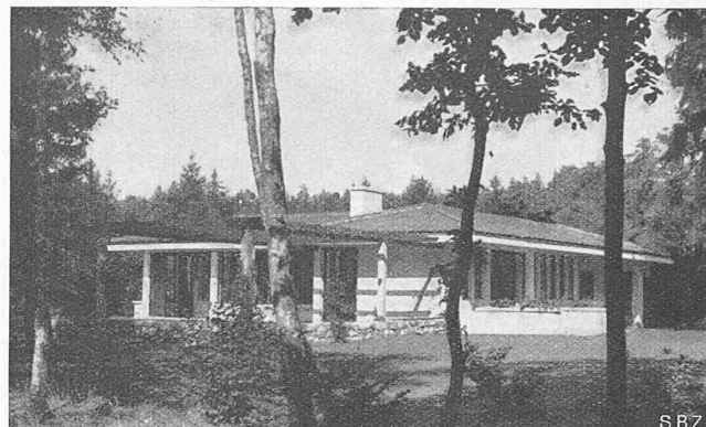
Abb. 8. Ansicht aus Osten
