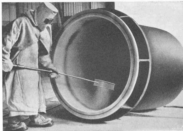
Abb. 3. Pudern eines Kessels mit hochsäurefestem Email
