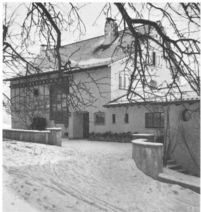
Abb. 8. Die Hofeinfahrt von der Stocklenflurstrasse im Winter
