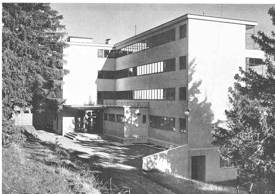
SANATORIUM BELLA LUI IN MONTANA-VERMALA, WALLIS ARCH. A. ITTEN, THUN, R. UND F. STEIGER, ZÜRICH
