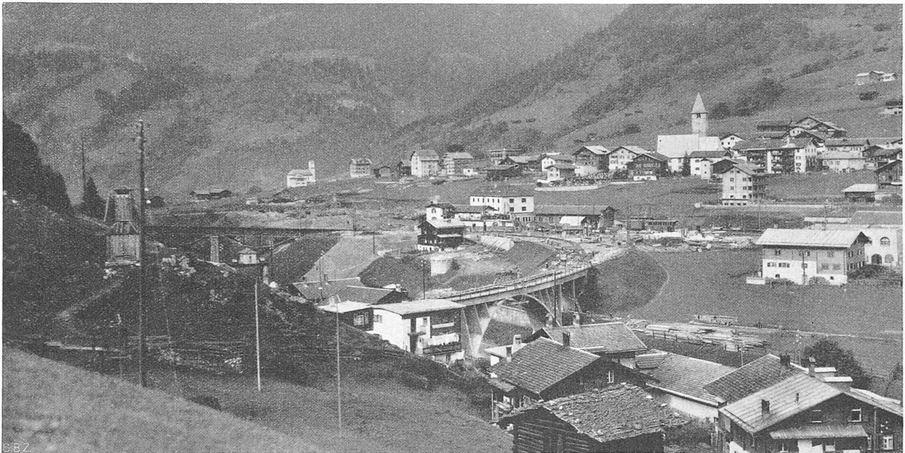
Abb. 1. Gesamtbild mit neuer und alter Landquartbrücke, aus Süden gesehen. In Bildmitte das neue Stationsgebäude.
