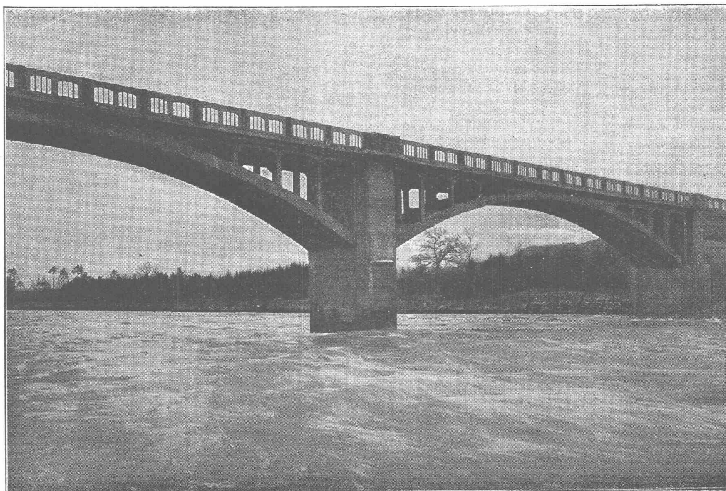
Strassenbrücke über die Thur bei Weinfelden
