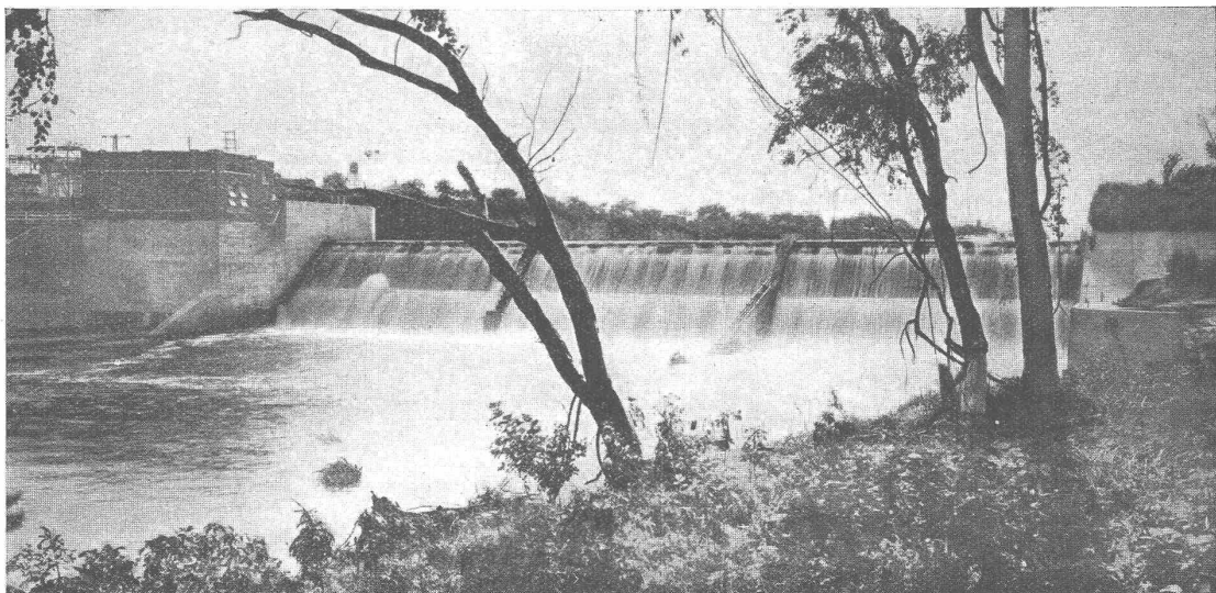
Dachwehr im Guadalupe River (Texas) mit drei Oeffnungen von je 26 m Breite und 3,65 m Höhe
