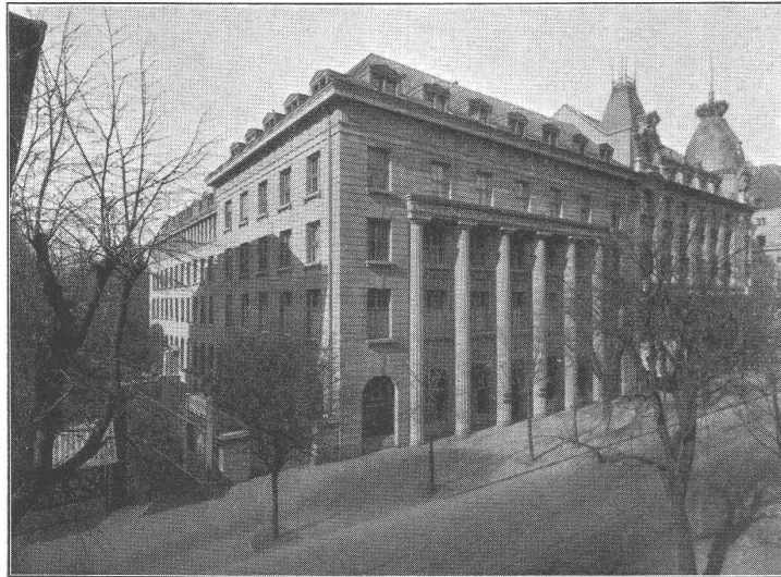
Verwaltungsgebäude des Geschäftssitzes Zürich
