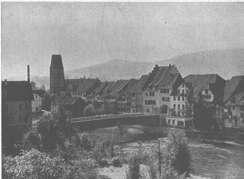
Eiserne Strassenbrücke über die Reuss in Mellingen.
