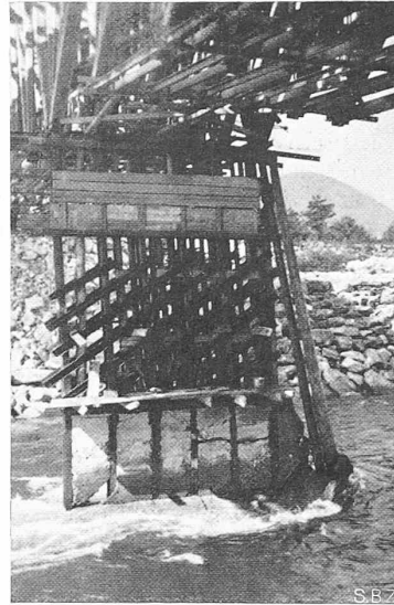
Abb. 11. Pfeilerzustand am 27. Juli. Abb. 6 bis 10 vom linken Ufer aus.
