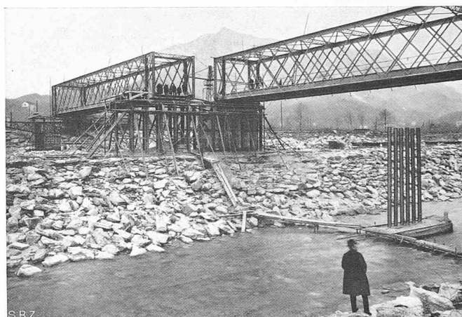
Abb. 4. Verschiebung der alten Brücke am 22./23. Febr. 1930, vom linken Ufer aus. Rechts die Stützen des Lehrgerüst-Pfeilers in der N-W-Rinne.
