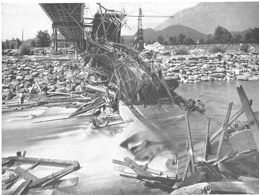
Abb. 2. Gesamtbild vom Einsturz am 29. Juli, vom linken Widerlager aus.
