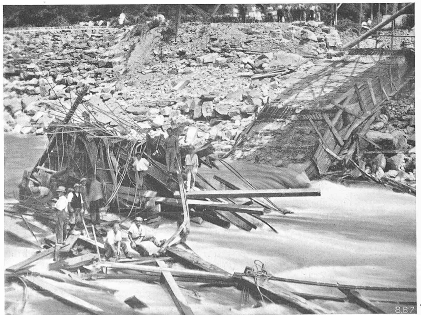
Abb. 13. Der Flusspfeiler nach dem Einsturz am 29. Juli 1930, vom rechten Ufer aus gesehen.
