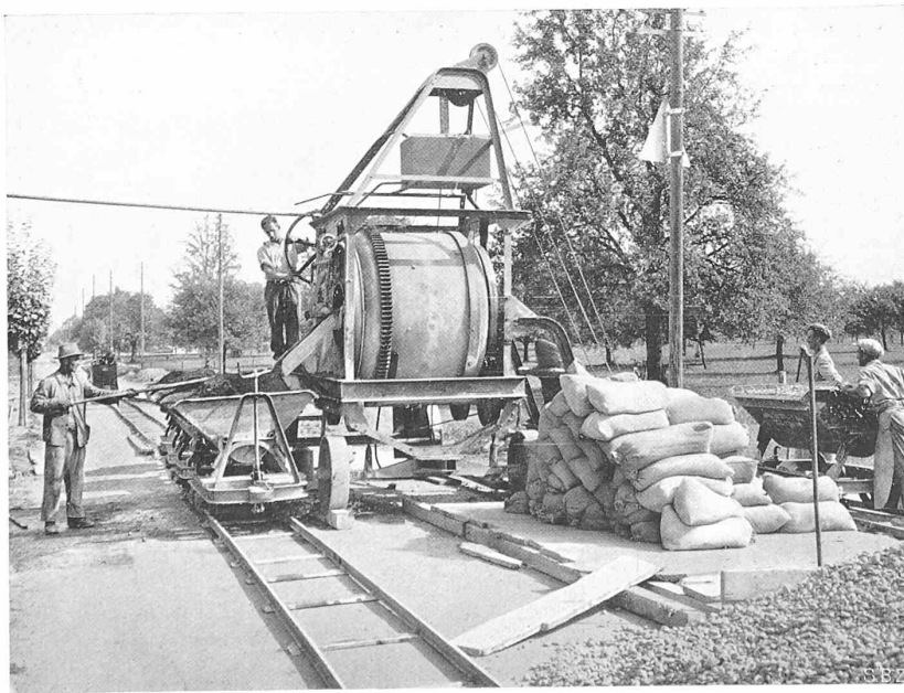
Abb. 3. Freifall-Betonmischer für 500 l Inhalt der stationären Anlage zwischen Arbon und Amriswil. Bauart der v. Rollschon Eisenwerke Rondez (Schweiz).
