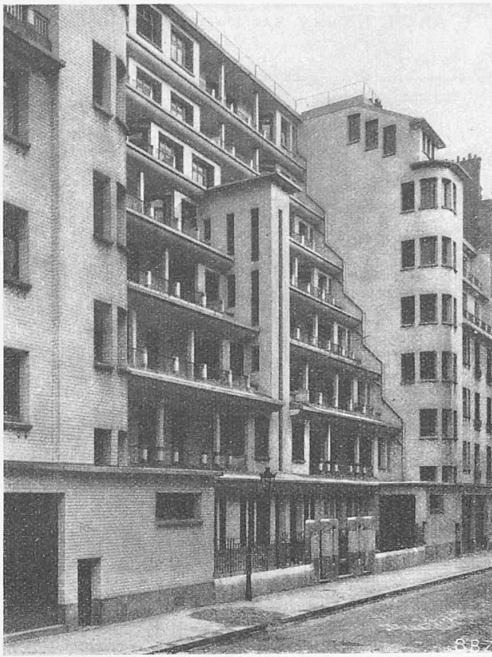
Abb. 1. Eine der Längsseiten des Baublocks.
