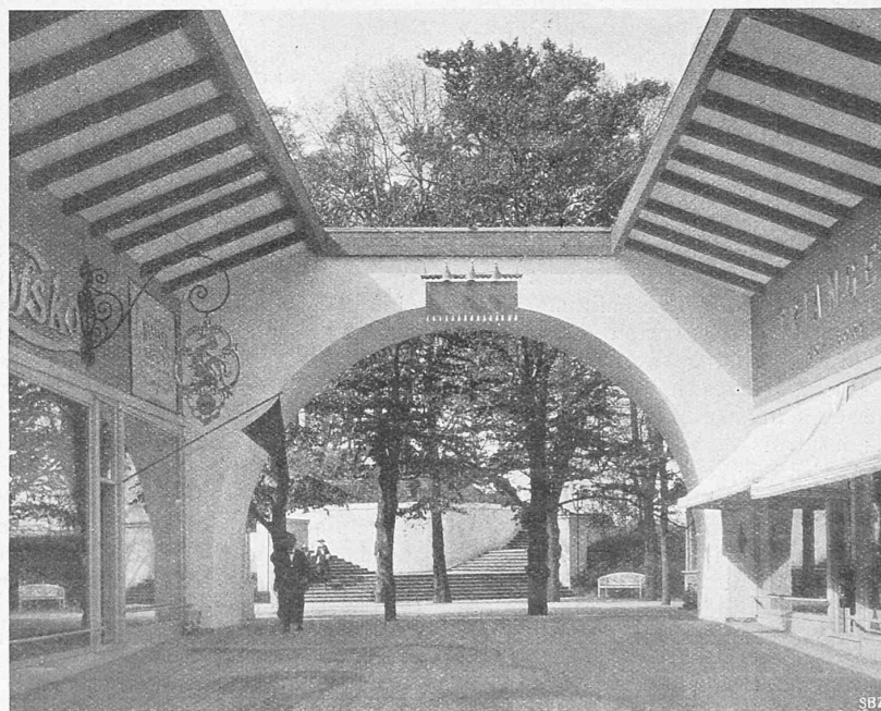
Abb. 7. Der „Viadukt“, eine als Magazingasse eingerichtete Holzbrücke zur Ueberbrückung einer Strasse. Bunte Behandlung in rotbraun, grau, blau und grün.
