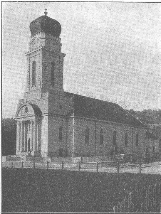
Katholische Kirche „Zum guten Hirten“ in Zürich-Wipkingen. Architekt: A. Higi, Zürich.
