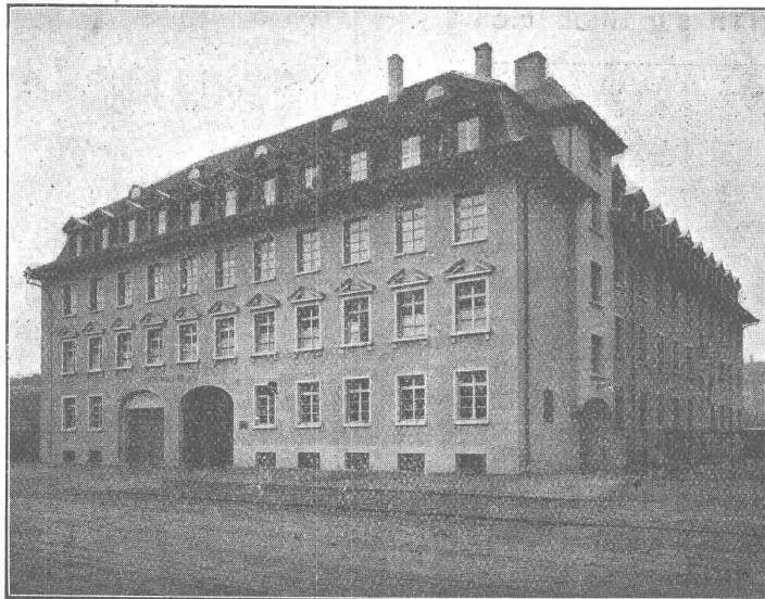
Neubau der Otto Fischer A.-G., Sihlquai 125, Zürich 5 Engrosvertrieb und Fabrikation elektrotechnischer Bedarfsartikel
