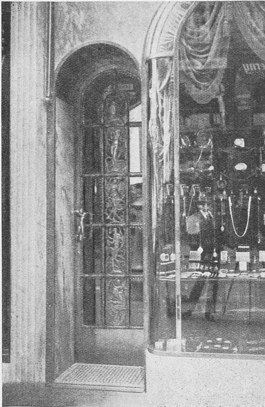
Abb. 22. Detail eines Juwelengeschäftes. Architekt Liebl. Türe aus getriebenem Bronzeblech.
