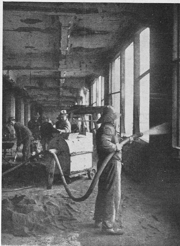
Abb. 6. Betonspritzverfahren der „Kraftbau“-Ges. Berlin
