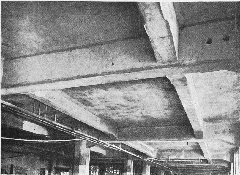
Abb. 5. Wiederhergestellte Unterzüge und Decken der Sarotti-Fabrik.
