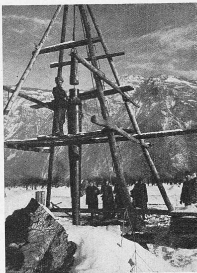
Abb. 25. Pilotierung im Gelände des Anschlussbahnhofs Auer.
