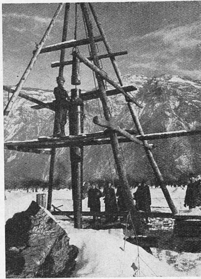
Abb. 25. Pilotierung im Gelände des Anschlussbahnhofs Auer.
