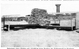
Belastung eines Pfahls mit 120 000 kg beim Neubau der Vulkanwerk in Hamburg Fig. 5
