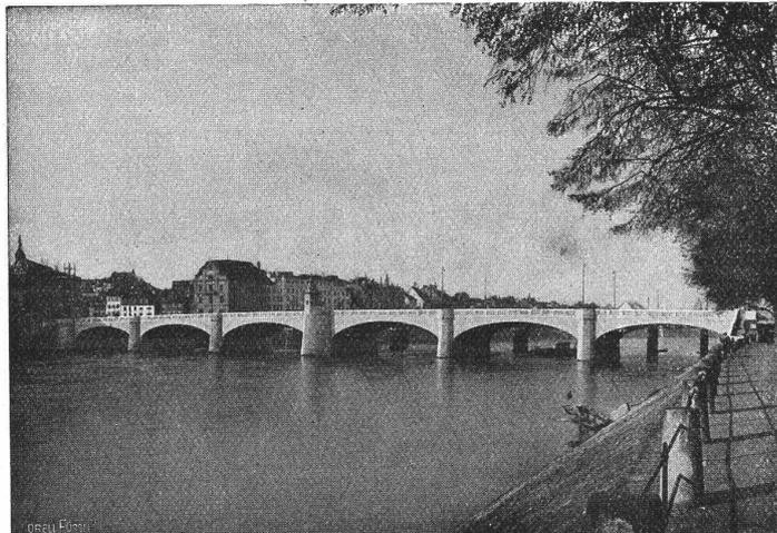
Mittlere Rheinbrücke in Basel, 200 m lang u. 18 m breit (Verkleidung sämtlicher Flächen in Gotthardgranit).
