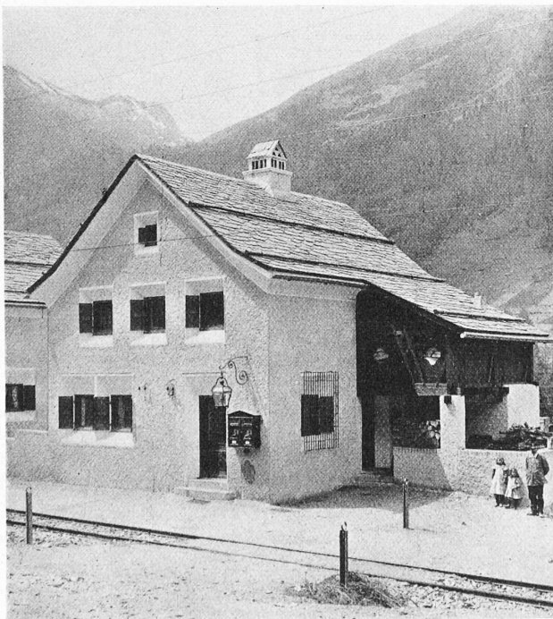
Abb. 4. Blockstation und Ausweiche-Stelle Carolina.
