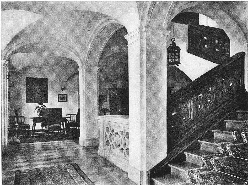
Treppenhaus mit Diele im Erdgeschoss (unten) und im I. Stock (oben)
